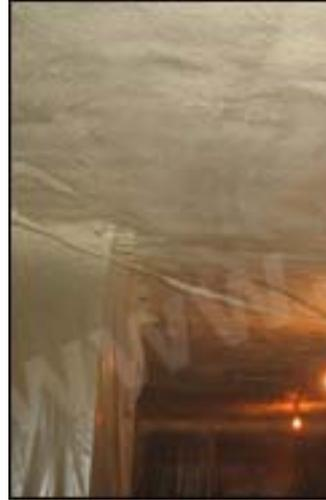
ППУ окружает нас везде: матрасы и подушки на которых мы спим, элементы декора, теплоизоляция холодильника, сиденья и отделка в машинах, высокопрочные краски и лаки и многое, многое другое. Одно из основных применений **ППУ** - технология нанесения строительной теплоизоляции на месте строительства методом напыления.
